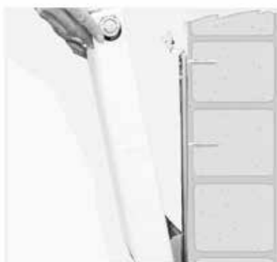
Heizkörper unten einhängen.
