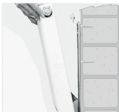
Heizkörper unten einhängen.
