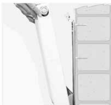
Heizkörper unten einhängen.
